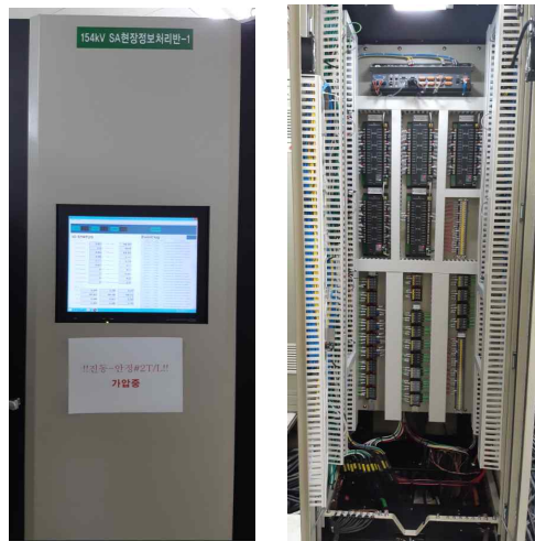
그림4. 설치된 IEC 61850 기반 현장정보처리반
